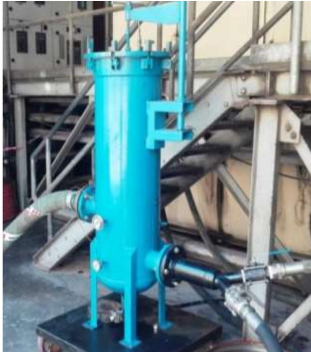
Equipo de Filtración de Alta Eficiencia
