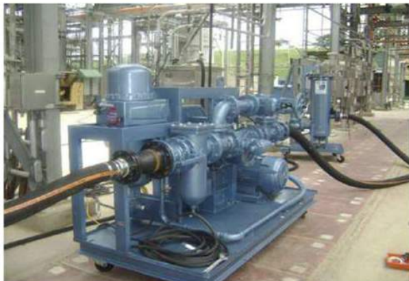
Equipo de bombeo externo para la realización del flushing Oleohidráulico de alta velocidad.
